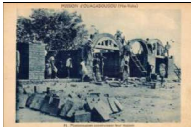
Missionnaires construisant leur maison (n° 81)
