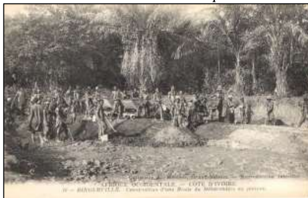
16- BINGERVILLE - Construction d'une Route du Débarcadère au plateau
