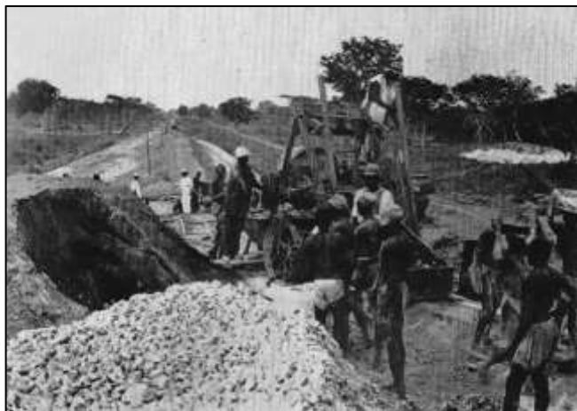
Bétonnière sur la plateforme (Cliché Génie Militaire)
